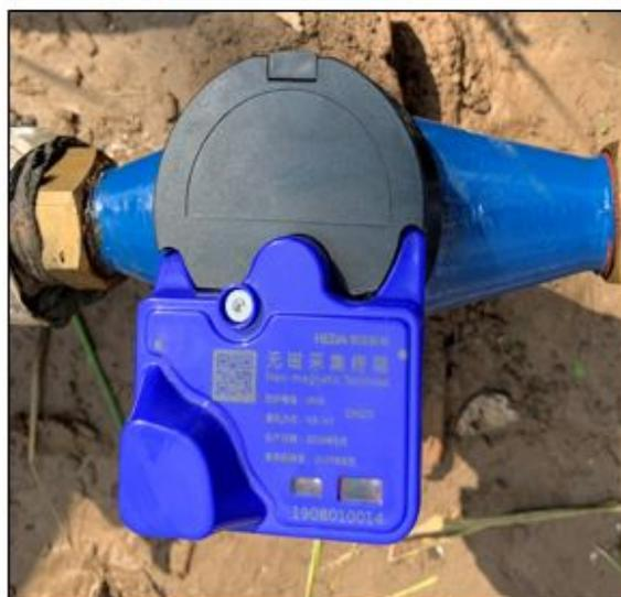
工业物联网水表的原理是基于窄带物联网技术（NB-IoT）将水表计量数据远程传输至数据接收终端（如，上海化工中法的智慧水务平台）。不同于传统的
